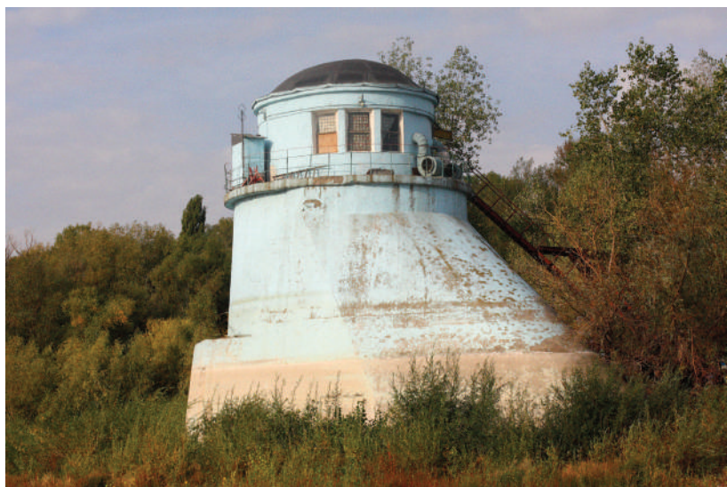
Насосная станция «Биоден»
