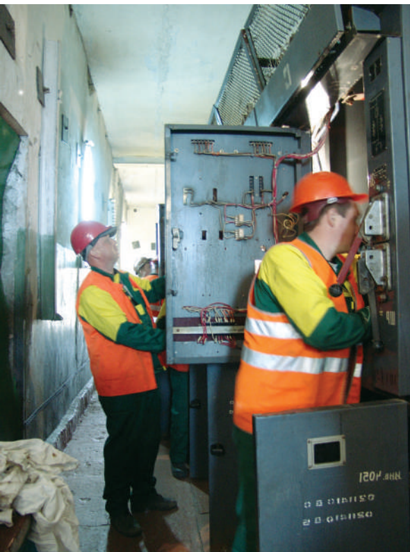
Энергоремонтный цех выполняет ремонтные работы на распределительном устройстве ВОС Краснооктябрьского района
