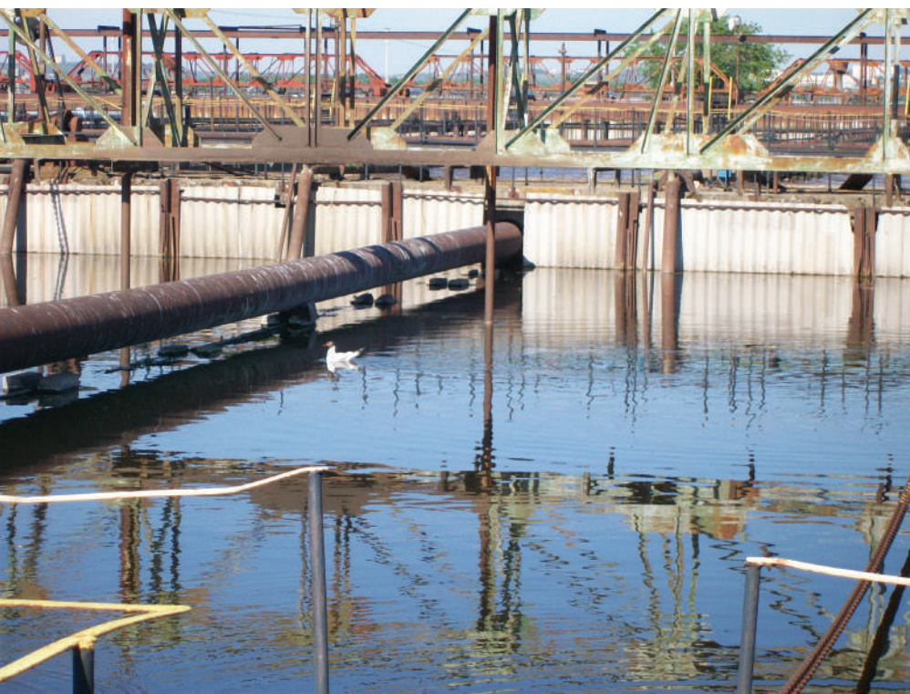
Вторичный отстойник блока № 1 ОСК на острове Голодном
