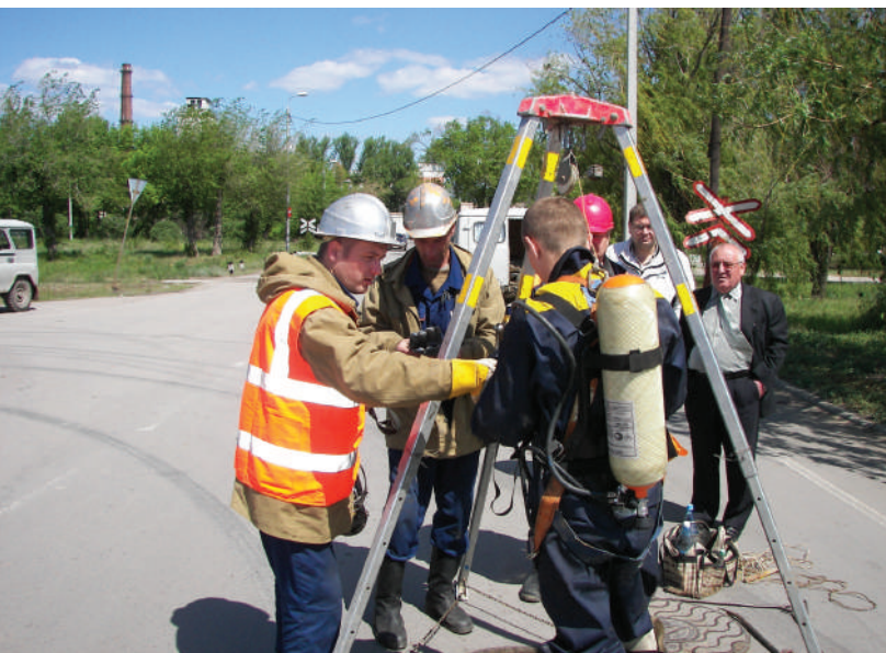
Бригада АВР цеха по ремонту сетей
