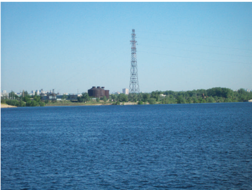
Очистные сооружения канализации на острове Голодном. Вид с Воложки Куропатки
