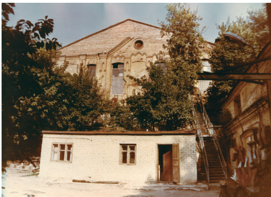
Центральный водопровод. Здание фильтров
