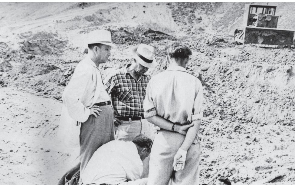
Строительство ВОС Краснооктябрьского района. А.Н. Ревин, А.П. Потапкин
