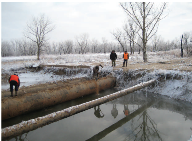
Ремонт напорного коллектора диаметром 1000 мм на о. Голодном. Зима 2008 года
