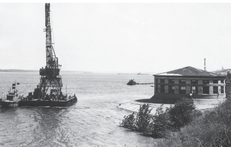
Насосная станция I подъема ВОС Кировского района
