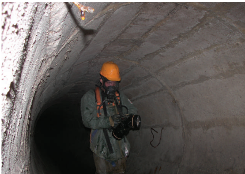
Осмотр канализационного коллектора
