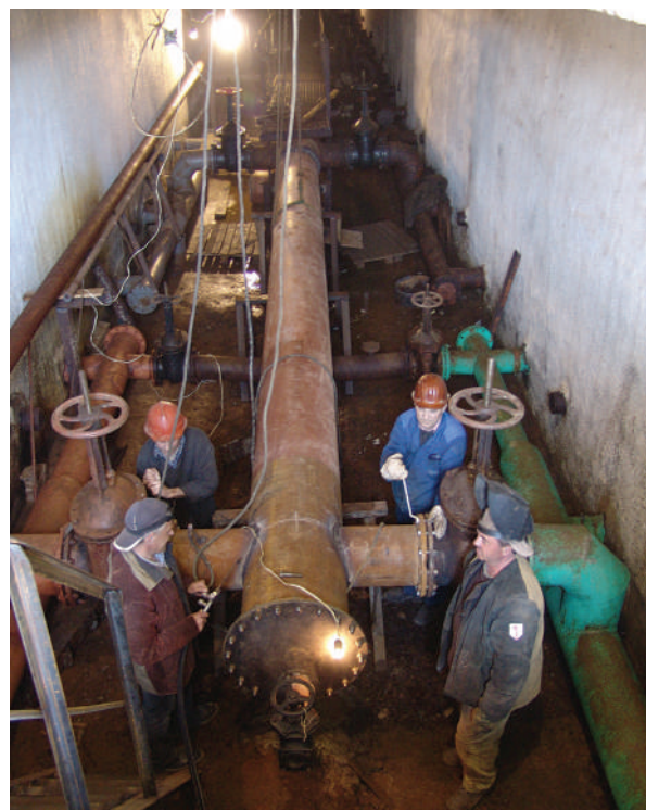
Замена трубопровода на ВОС Краснооктябрьского района
