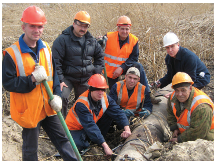
Аварийная бригада цеха ВКХ Кировского района
