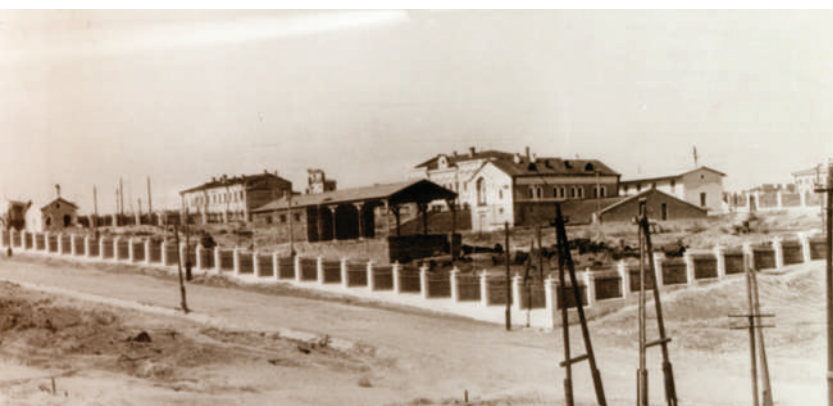
Отстойник центрального водопровода
