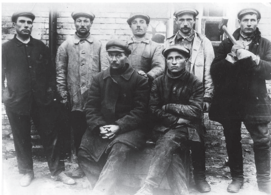
Рабочие горканализации. 1930 год
