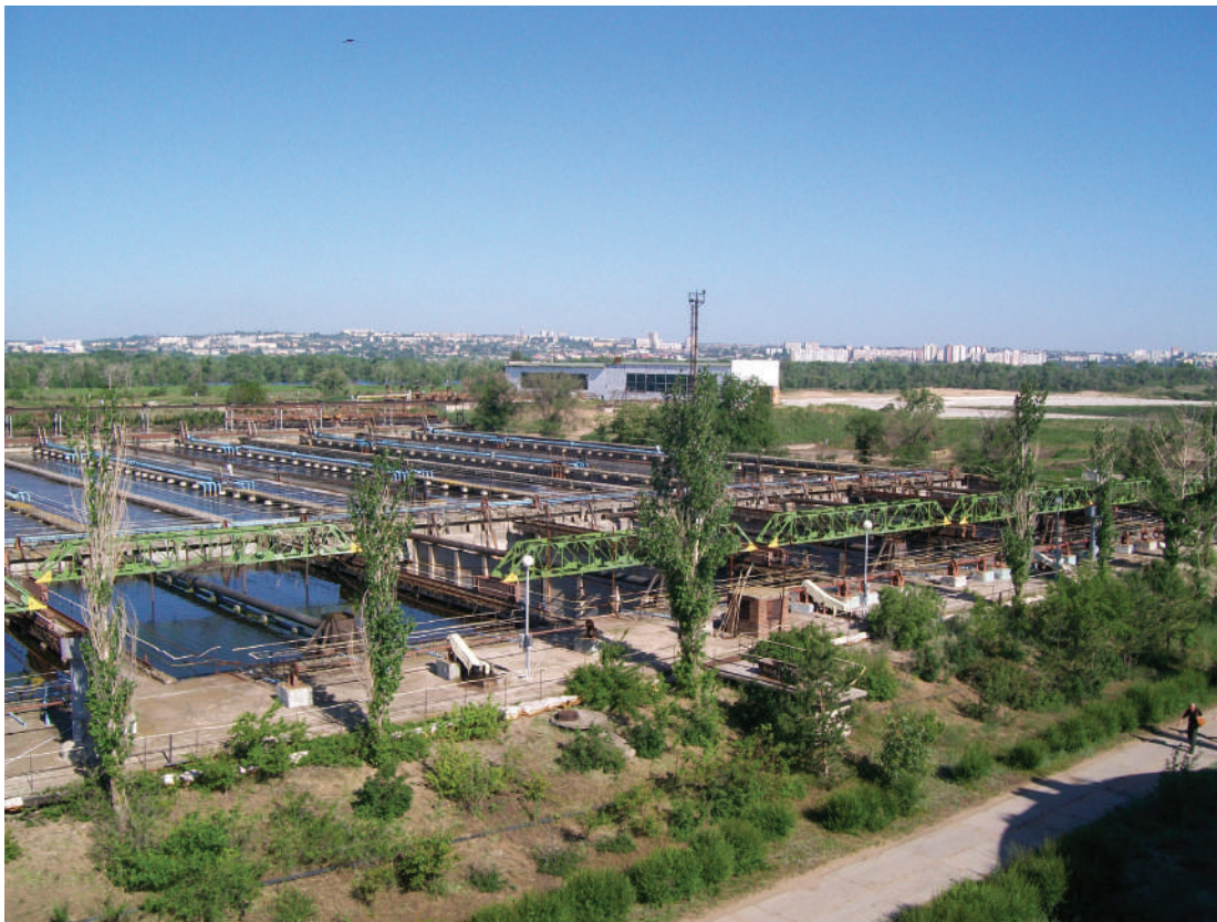
Блок № 1 очистных сооружений канализации на острове Голодном
