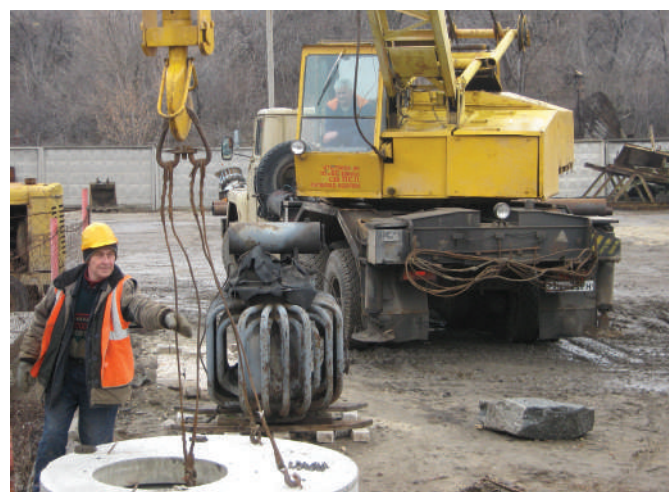
Ремонт магистральных водопроводов
