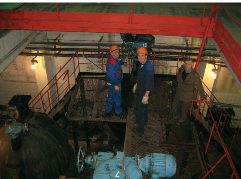
Ремонтные работы на Главной канализационной насосной станции
