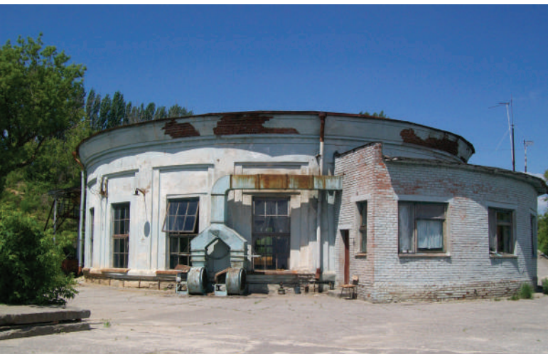
Станция первого подъема ВОС Тракторозаводского района № 1
