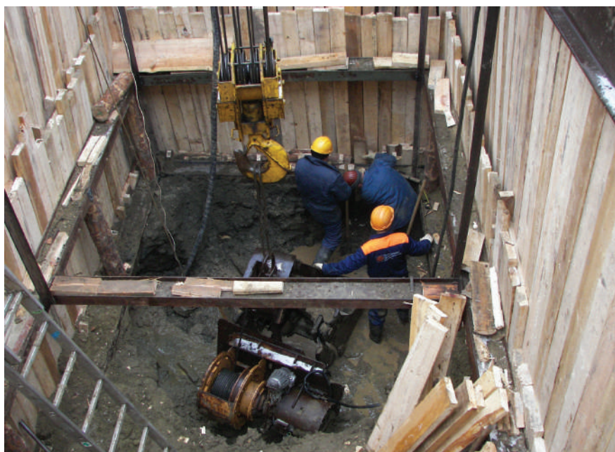
Цех по ремонту сетей. Ремонт всасывающего трубопровода насосной станции первого подъема ВОС Центрального района
