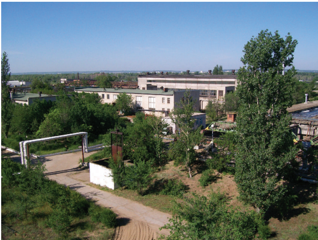
Административно-бытовой корпус, здание ремонтно-механического участка и котельная очистных сооружений канализации о. Голодный
