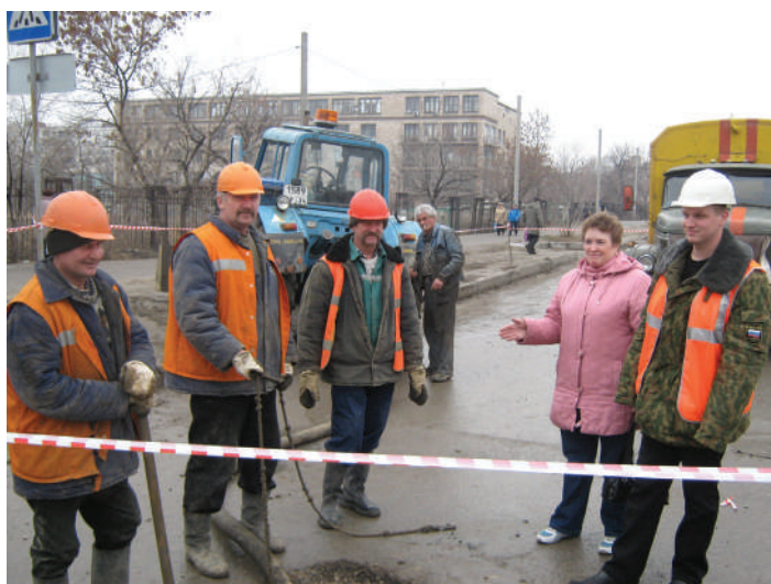
Цех ВКХ Краснооктябрьского района. Аварийная бригада во главе с мастером А.М.Дергачевой.
