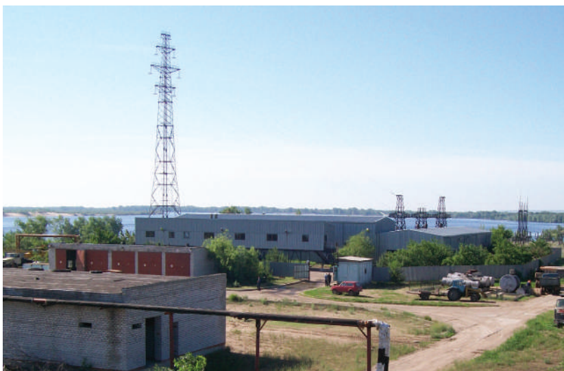
Цех механического обезвоживания осадков сточных вод
