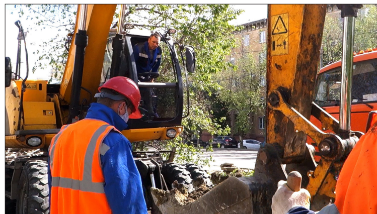
Замена сетей требует виртуозного мастерства экскаваторщика.
