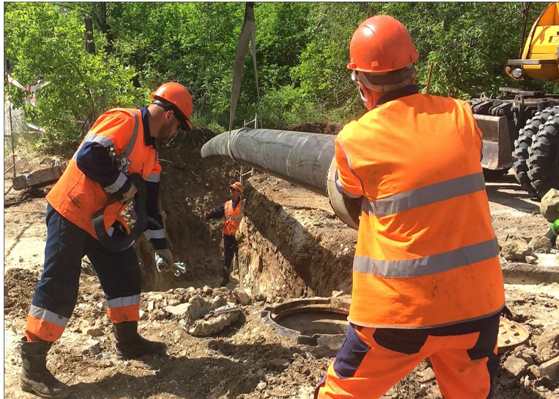
Замену сетей в Тракторозаводском районе ведет цех капитального ремонта «Концессий водоснабжения».
