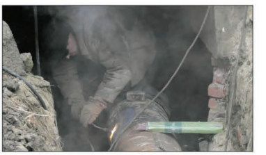
Вести сварку, когда труба заполнена водой, невозможно.
