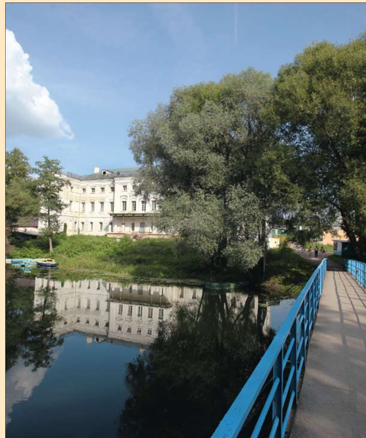
Пешеходный мост в Полотняном Заводе
