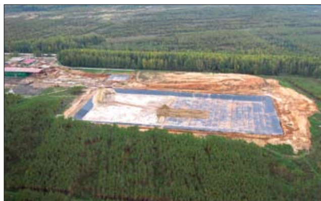
Полигон по переработке ТБО в Нижегородской области
