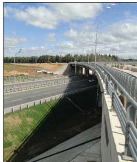
Строительство нового выхода на МКАД с федеральной автомобильной дороги М1 «Беларусь» Москва– Минск»
