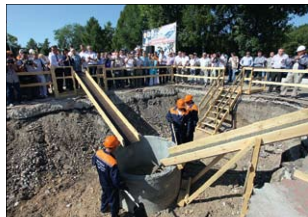
Закладка капсулы в фундамент Ледового дворца
