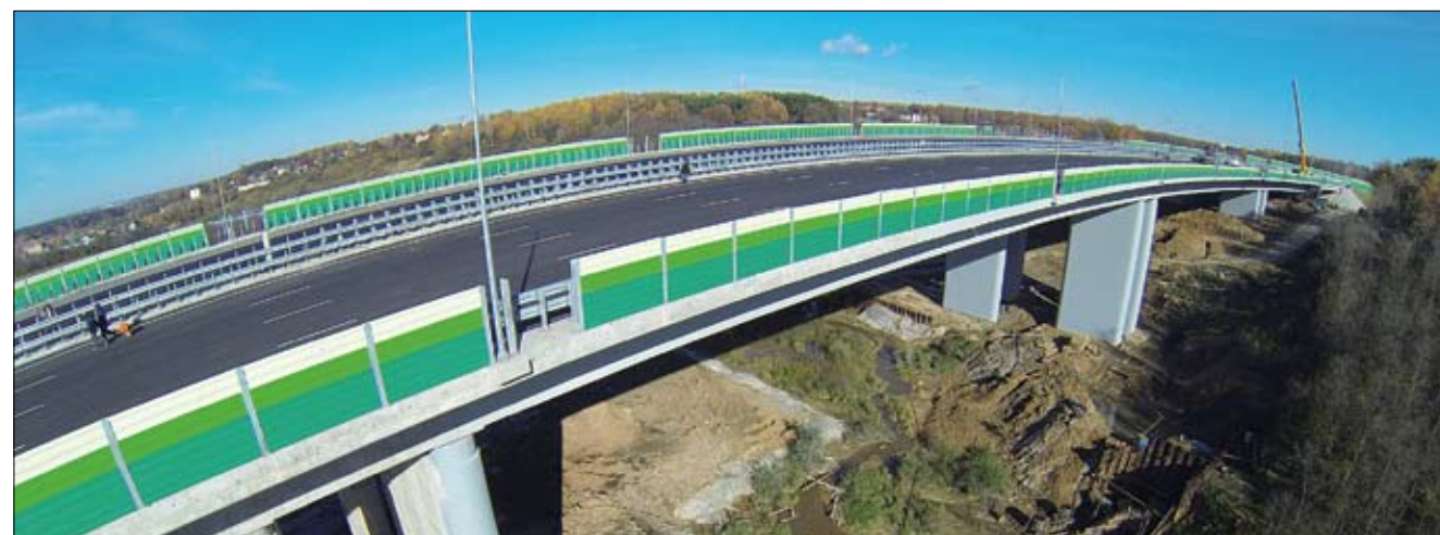
Мост-эстакада через р. Чаченка (519 м)
