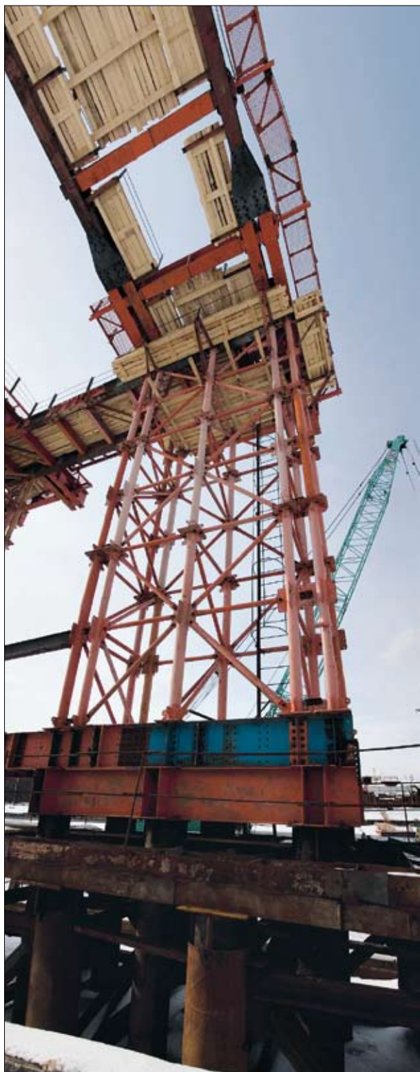
Строительство моста на трассе М11 через канал им. Москвы
