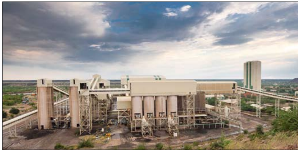
Современный завод Орапа. Габороне, Ботсвана
