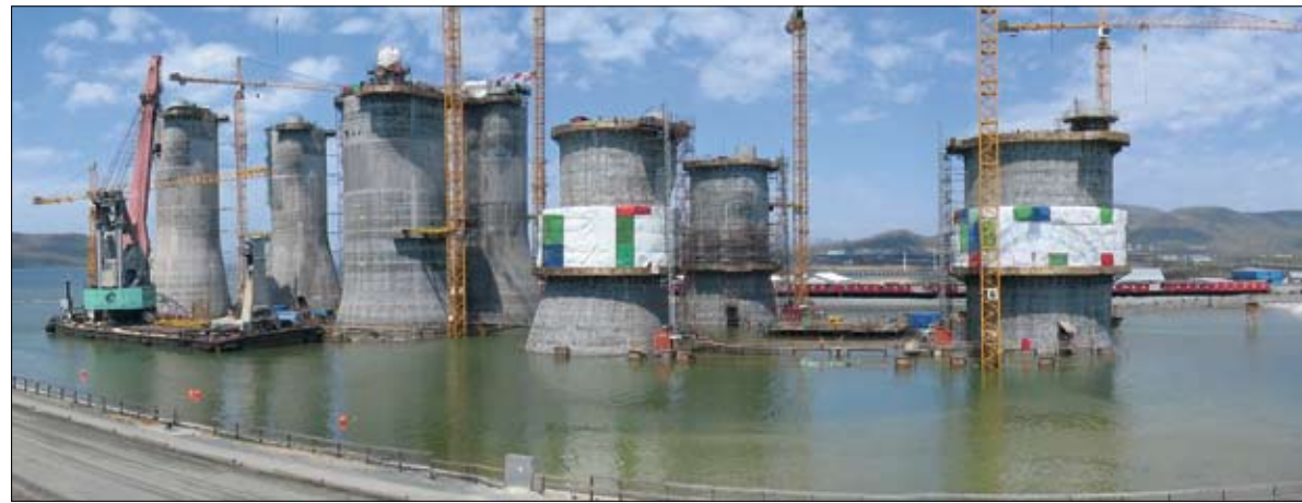
Строительство оснований платформ по проекту Сахалин-2
