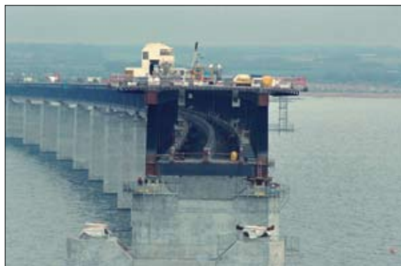
По нижнему этажу движутся в двух направлениях поезда, по верхнему в четыре полосы – автомобили
